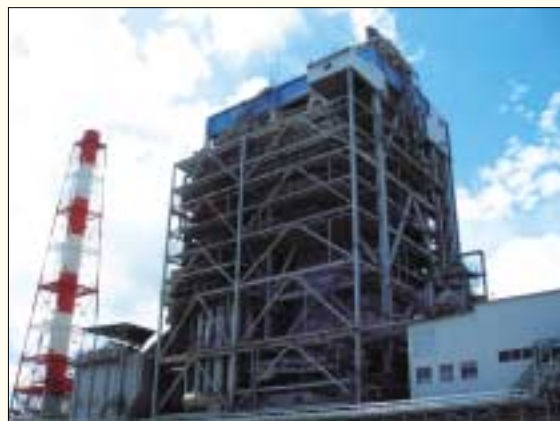
「オキシノン®MFシリーズ」が使用されている発電用ボイラ
